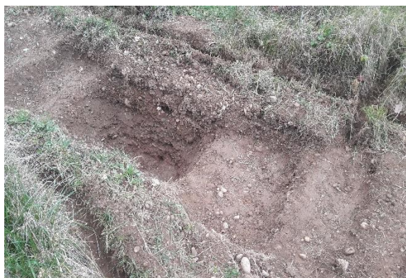
Creusement en étages afin de créer différentes hauteurs
